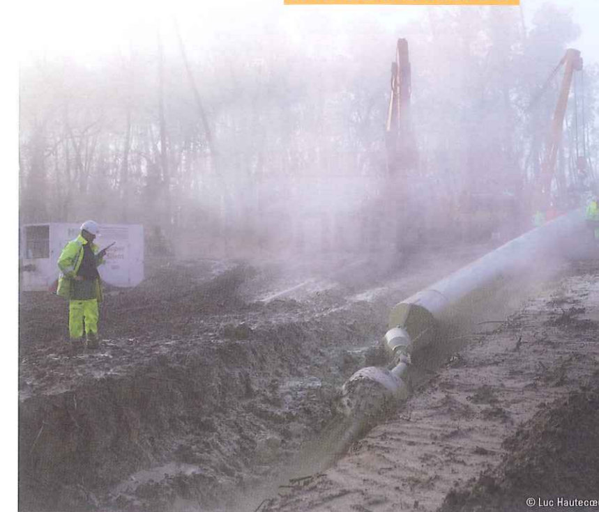
Tirage de la canalisation sous le cours d'eau (la Douze).
