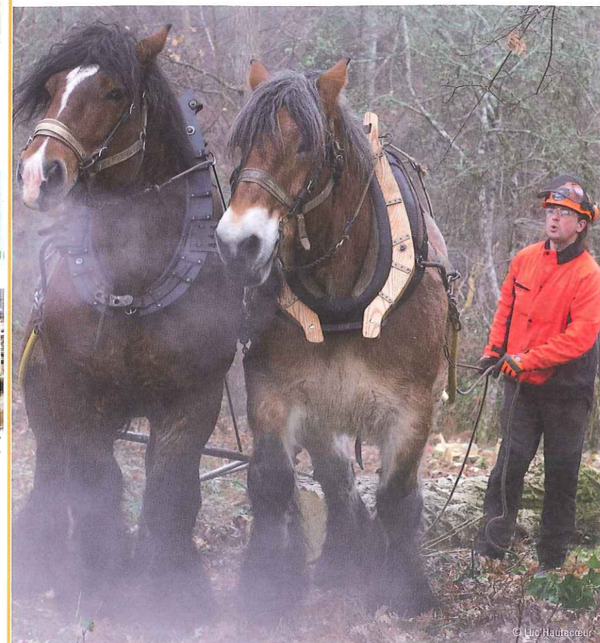
Débardage par des chevaux sur le chantier de gazoduc Girland.
